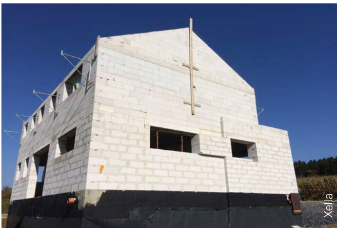
Fig. 2 Maçonnerie portante isolante en béton cellulaire destinée à être parachevée avec un enduit extérieur.
