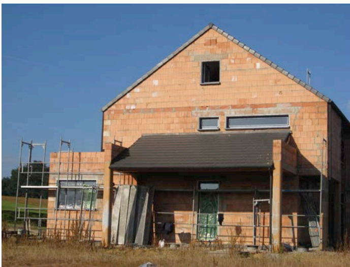
Fig. 1 Maçonnerie portante isolante en blocs treillis en terre cuite destinée à être parachevée avec un enduit extérieur. Situation avant et après l'enduisage.
