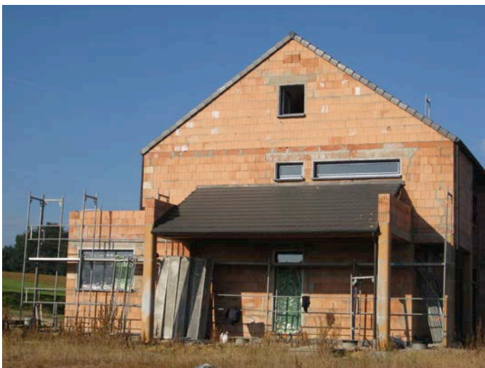
Afb. 1 Dragend isolerend metselwerk uit snelbouwstenen uit gebakken aarde dat bestemd is om afgewerkt te worden met een buitenbepleistering. Situatie vóór en na de pleisterwerken.
