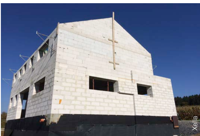
Afb. 2 Dragend isolerend metselwerk uit cellenbeton dat bestemd is om afgewerkt te worden met een buitenbepleistering.
