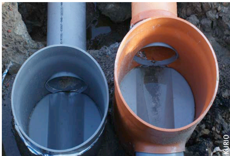
Afb. 1 Hemelwater en afvalwater moeten gescheiden afgevoerd worden op het perceel.
