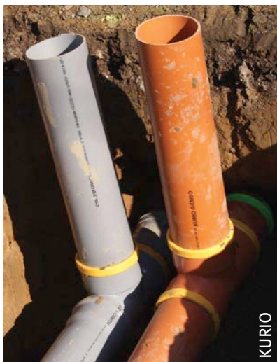
Afb. 1 Hemelwater en afvalwater moeten gescheiden afgevoerd worden op het perceel.
