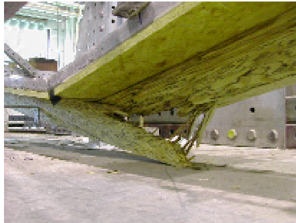
Figure 11 Rupture au niveau de la poutre en bois.
