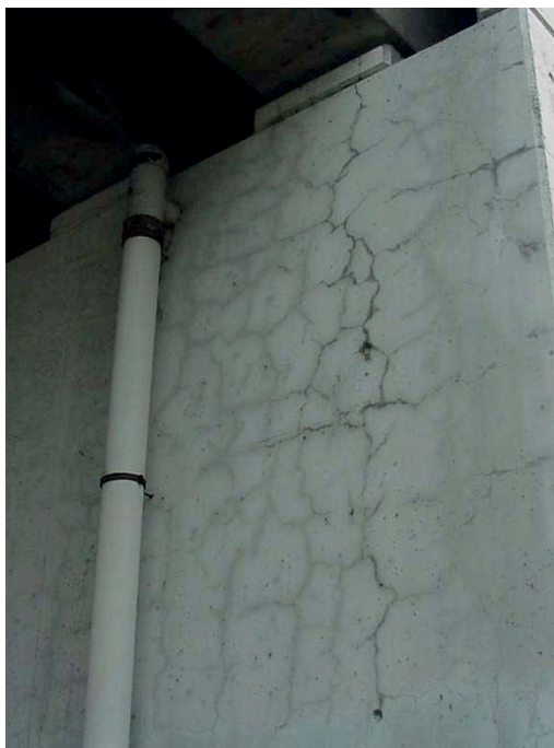
Afb. 3 Betonconstructie die aangetast is door een alkali-silicareactie.
