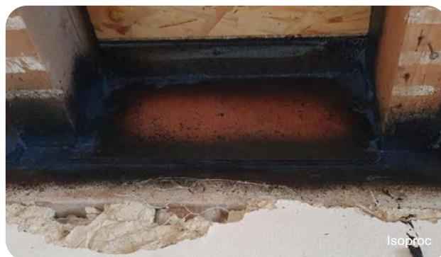
**3** **4** Étanchéification de traversées d'éléments de la charpente à l'aide d'un *tape* adapté (à gauche) ou d'une étanchéité à l'air appliquée sous forme liquide (à droite).
