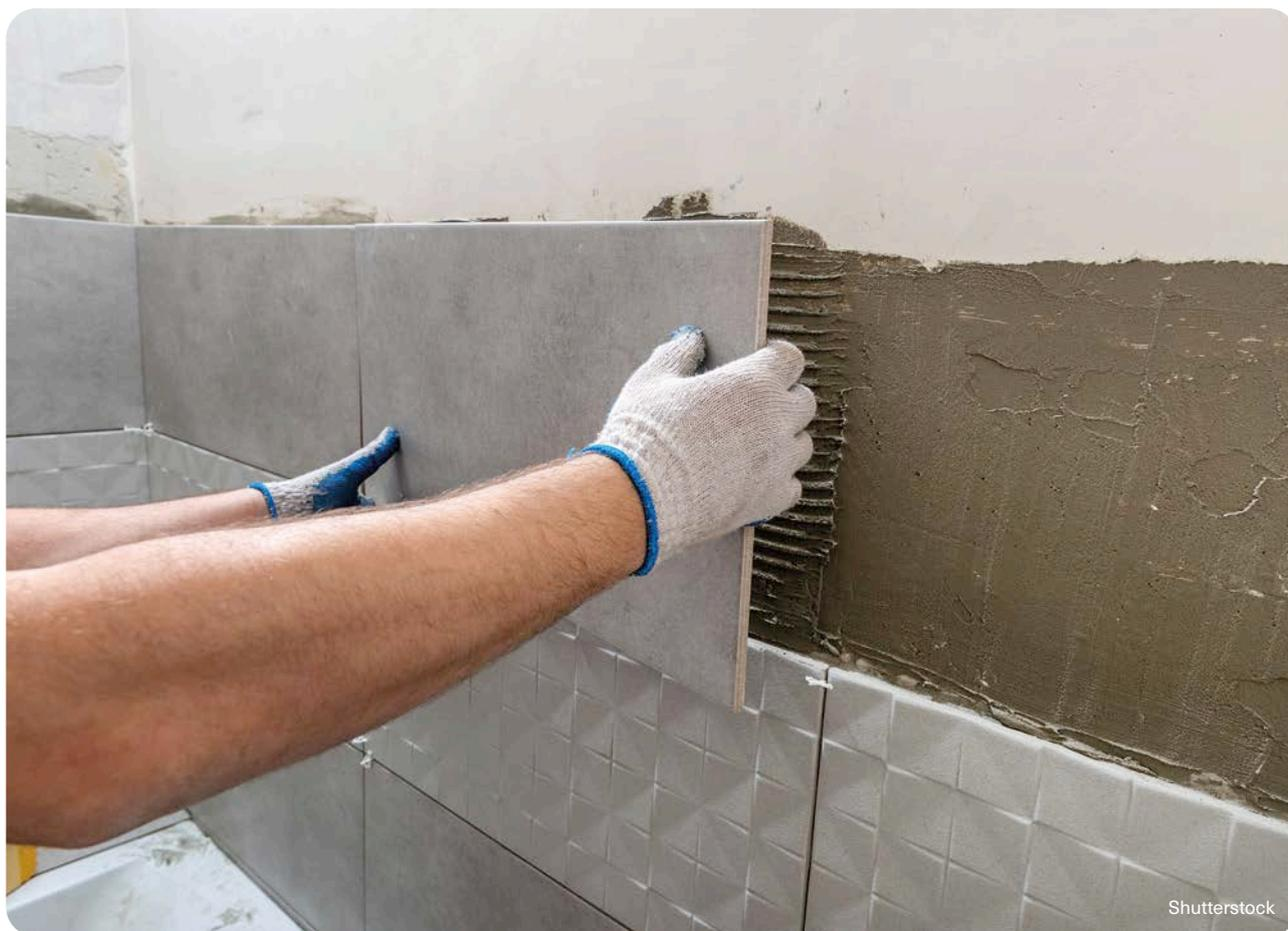
tion entre le ciment et le plâtre engendre des **sels expansifs** (ettringite, également appelé sel de Candlot). Ces derniers sont alors susceptibles de provoquer le décollement des carreaux. Il en va de même de la membrane d'étanchéité si elle est appliquée au moyen d'un ciment-colle sur un enduit humide à base de plâtre. Il importe donc de vérifier attentivement le taux d'humidité de l'enduit et de ne commencer à carreler que lorsqu'il est sec.
