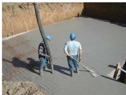
Fig. 4 Mise en œuvre à l'aide de béton autocompactant.
