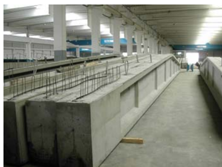
Fig. 3 Utilisation des BHP en préfabrication.
