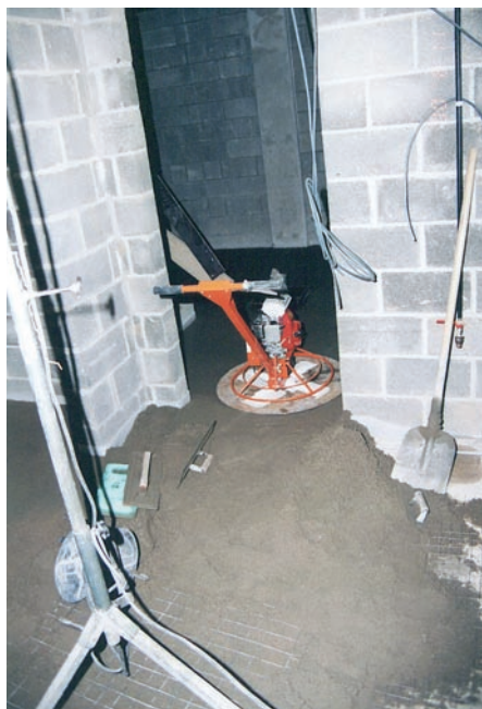
Fig. 2 Réalisation d'une chape compactée à la main.
