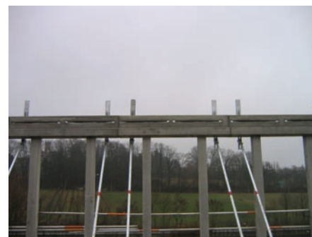
Étais tirant-poussant formant la base du garde-fou de l'étage supérieur.
