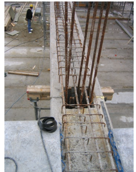
Une bonne planification des opérations d'assemblage permet d'améliorer considérablement la sécurité.
