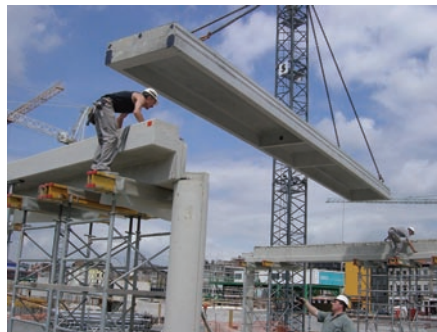
Les risques de chutes sont bien réels lors de la mise en place des éléments.
