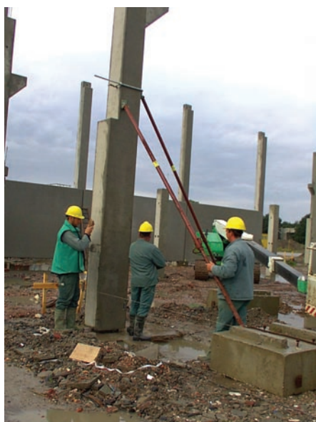
Mise en place d'un bloc d'étalement pour le montage d'une colonne.
