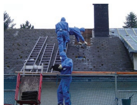
Enlèvement d'éléments en amiante-ciment se trouvant à l'extérieur.
