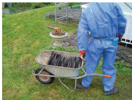
Fig. 2 Transport de l'amiante-ciment à l'aide d'une brouette.
