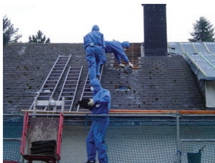
Fig. 1 Démontage en ambiance extérieure d'éléments en amiante-ciment.
