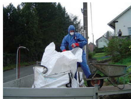
Fig. 3 Déversement de la brouette dans le sac spécial.
