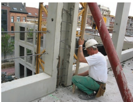
Cadre en béton avec garde-fou intégré sous forme d'une double barre d'armature.
