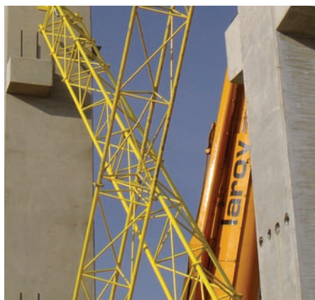
L'étaçonnement des colonnes hautes est ancré dans le massif de fondation de la colonne voisine.
