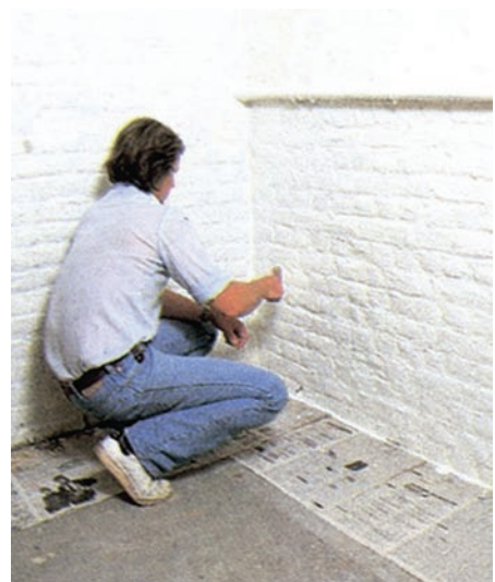
Fig. 12 Enduit d'imperméabilisation à base de résines époxydiques.
