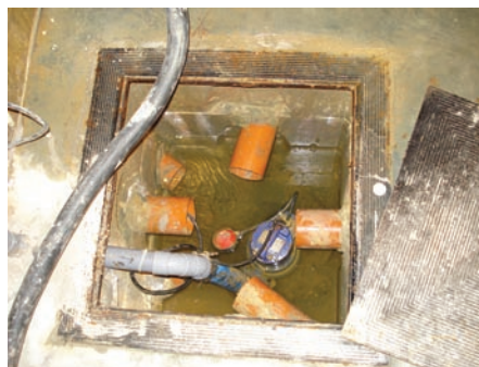
Fig. 9 Exemple d'un puisard de relevage.
