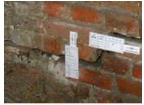
Fig. 8 Exemples de verniers placés sur une fissure.
