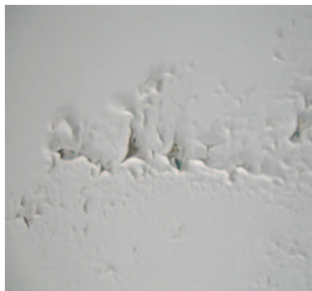
Fig. 1 Vieillesse d'une peinture à base de résine vinylique.
