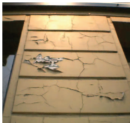
Fig. 2 Vieillesse d'une peinture à base de résine alkyde.
