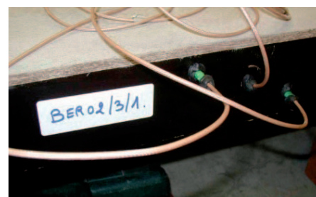
Fig. 6 Sonde hygrothermique placée horizontalement dans la chape.
