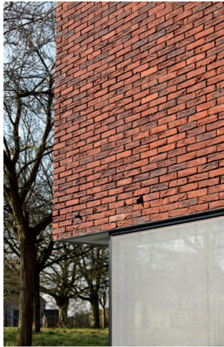
Fig. 28, 29 et 30 Maçonneries collées à joints minces. Éléments en terre cuite (cas 4).
