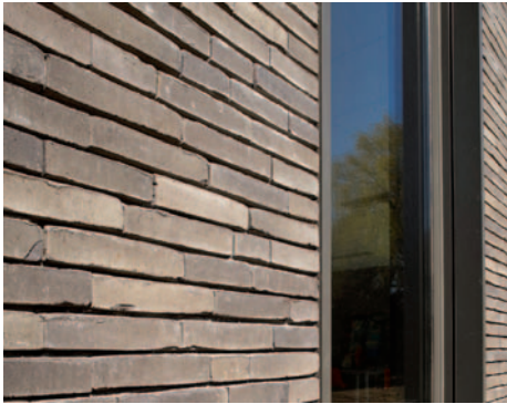
Fig. 28, 29 et 30 Maçonneries collées à joints minces. Éléments en terre cuite (cas 4).
