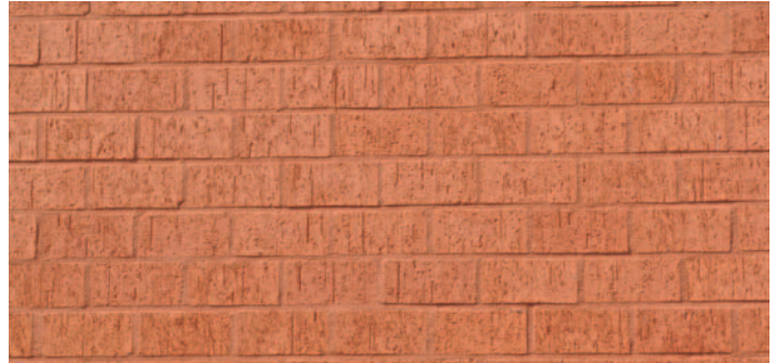
Fig. 21 Maçonnerie traditionnelle rejointoyée avec un mortier pigmenté. Éléments en terre cuite (cas 1).
