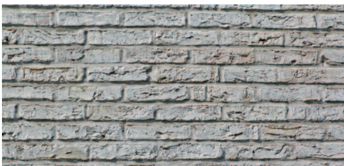
Fig. 26 Maçonnerie traditionnelle avec un type de briques irrégulières (irréaliste de spécifier un joint d'épaisseur régulière et trop mince) (cas 1).
