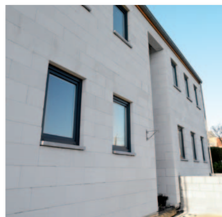
Fig. 10 Maçonnerie en éléments de béton cellulaire montée à joints minces (joints : 0,5-3 mm).
