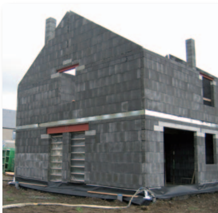
Fig. 11 Maçonnerie en éléments de béton léger montée à joints minces (joints : 0,5-3 mm).
