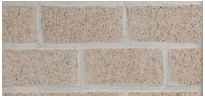
Fig. 21 Maçonnerie traditionnelle rejointoyée avec un mortier pigmenté. Éléments en terre cuite (cas 1).
