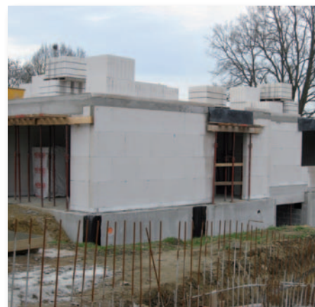
Fig. 12 Maçonnerie en éléments de silico-calcaire montée à joints minces (joints : 0,5-3 mm).
