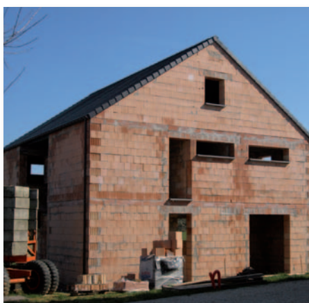
Fig. 9 Maçonnerie en éléments de terre cuite montée à joints minces (joints : 0,5-3 mm).
