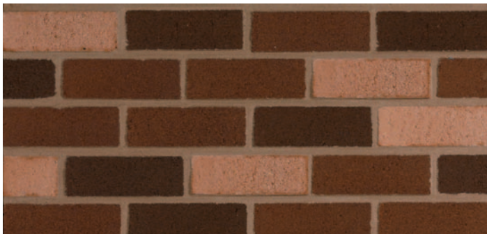
Fig. 22 et 23 Maçonneries traditionnelles. Éléments en béton (cas 1).
