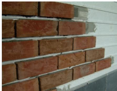
Briques encollées *in situ* sur l'isolant
