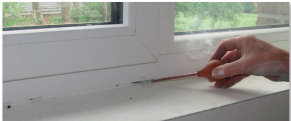
Fig. 3 Détection des fuites d'air lorsque le bâtiment est placé en dépression lors d'un essai de pressurisation
