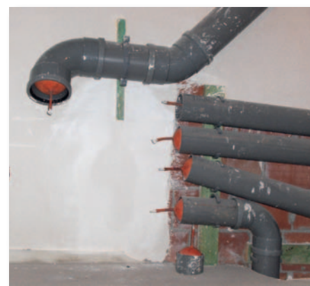
Fig. 2 Il est préférable de réaliser la barrière d'étanchéité à l'air avant la fixation des conduits le long d'un mur extérieur maçonnerie.
