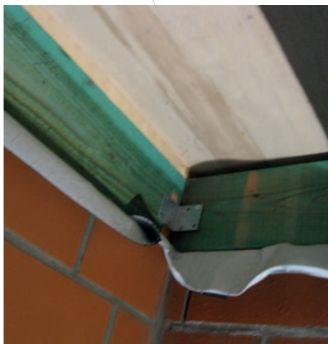
Fig. 4 et 5 Posé d'une membrane de raccord dans le cas de poutres posées tout le long de la paroi (sans ancrage)
