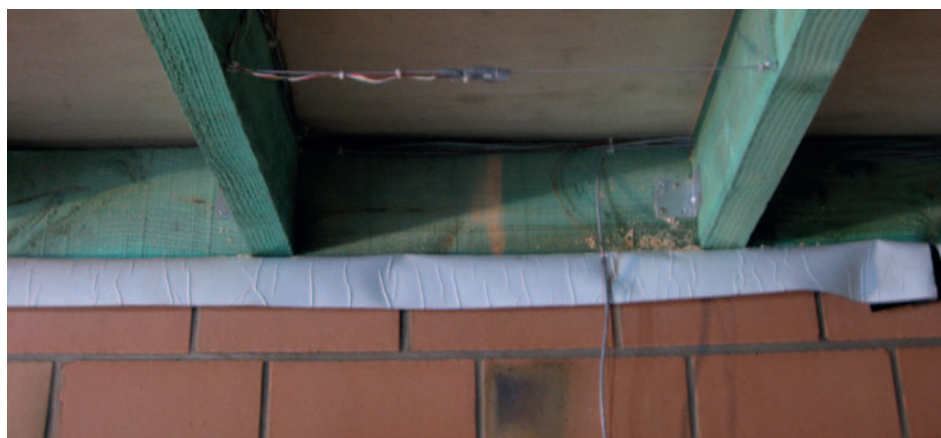
Fig. 2 et 3 Pose d'une membrane dans le cas de poutres appuyées sur la maçonnerie (les entretoises en bois séparant les poutres peuvent éventuellement être remplacées par une maçonnerie)
