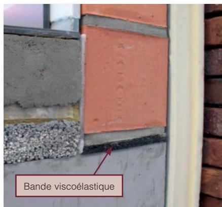
**Bande viscoélastique utilisée au droit des jonctions plancher/mur afin de réduire les transmissions latérales**
