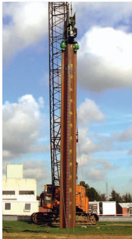
Mise en œuvre d'une palplanche par vibrofonçage
