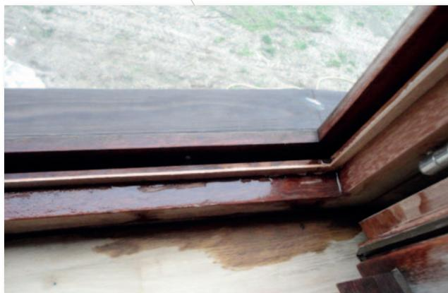
L'étanchéité à l'eau des menuiseries en bois sans traitement de finition n'est pas toujours garantie
