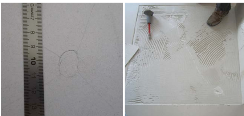
1 et 2 | Fissuration et dégradation par poinçonnement d'un carreau de très grand format et de très faible épaisseur (à gauche) en raison d'un encollage insuffisant (à droite)
