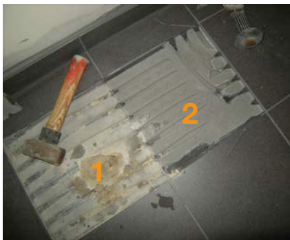
5 et 6 | Décollement d'un carrelage sur chape anhydrite
