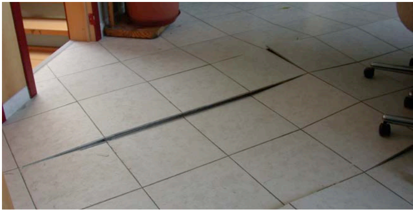
3 | Soulèvement de carrelage sur chape durcie
