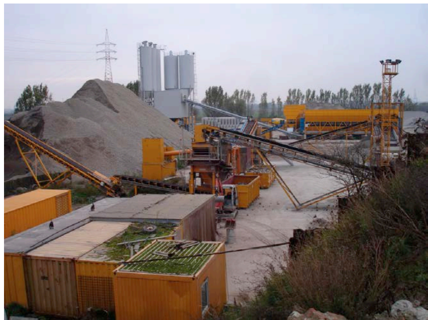
1 | Vue d'une centrale à béton équipée d'installations de recyclage (©ARC).
