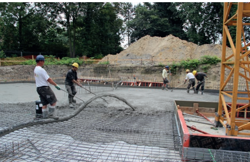
Mise en œuvre d'un radier avec armature mixte
