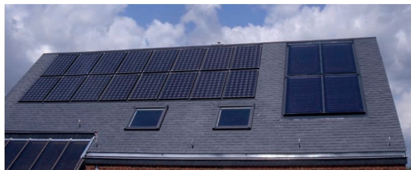
Montage de capteurs photovoltaïques (à gauche) et thermiques (à droite) en intégration
