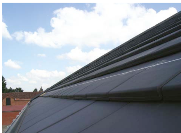
3 | Mesure de la flèche d'une couverture.
