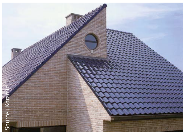
2 | Tuiles correctement posées.
