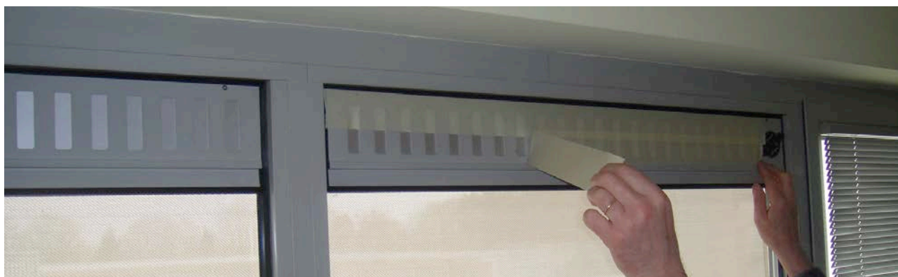
Scellement d'une ouverture de ventilation au moyen d'une bande adhésive
