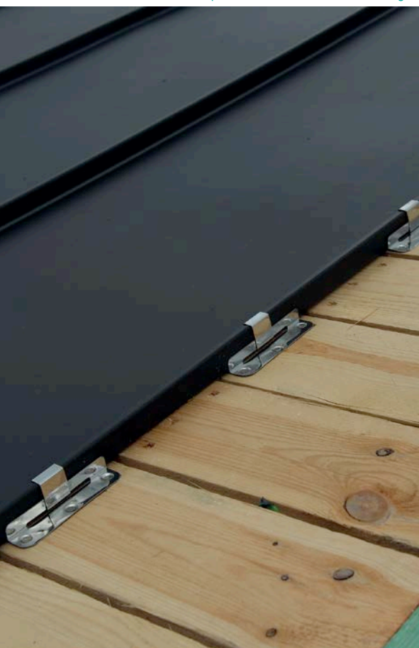
Fixation des pattes coulissantes sur les voliges
