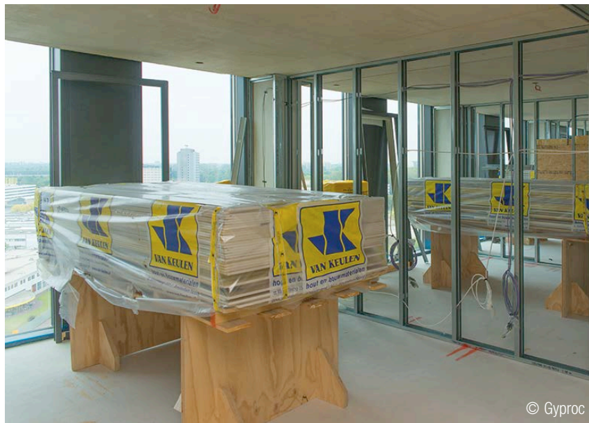
2 | Lots de plaques prédécoupées préparés pour chaque local grâce aux informations extraites de la maquette numérique.
