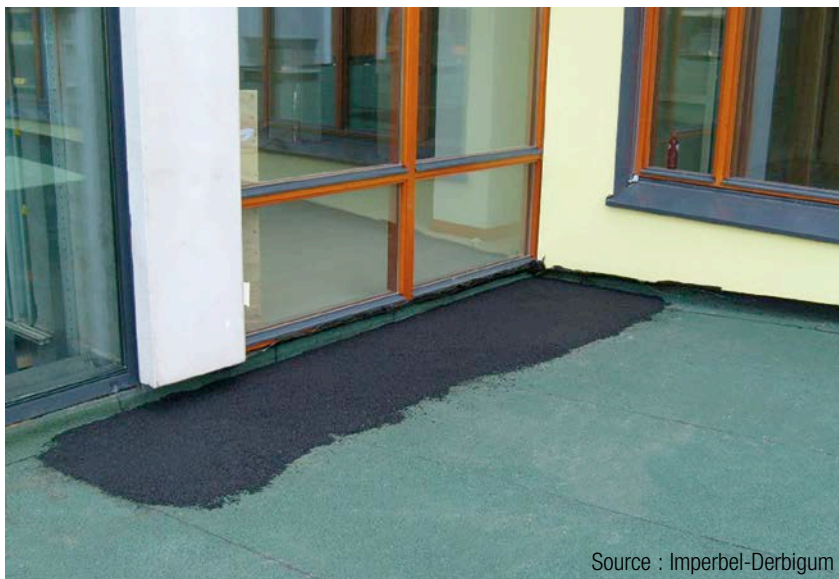
2 | Masse bitumeuse de remise à niveau.
