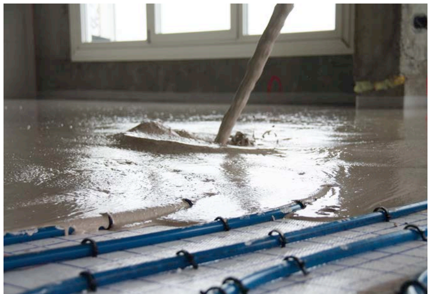
Mise en œuvre d’une chape à base de sulfate de calcium.
