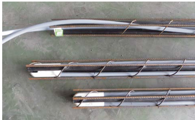
1 | Echangeur de chaleur avec conduite en forme de U fixé dans une cage d'armature.
