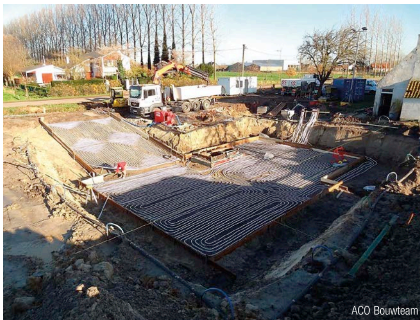
2 | Échangeurs de chaleur posés dans un lit de sable sous le radier.
