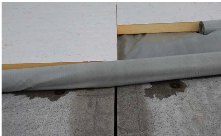
2 | Mise en œuvre du pare-vapeur sur des éléments TT.
