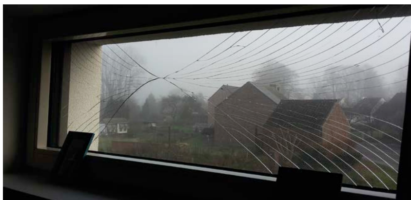
1 | Type de casse d'un vitrage isolant de petites dimensions fréquemment observé durant les périodes hivernales anticycloniques.
