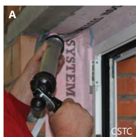
Types de membranes d'étanchéité à l'air et/ou à la vapeur destinés aux raccords de fenêtres.
