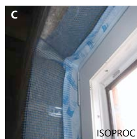
Types de membranes d'étanchéité à l'air et/ou à la vapeur destinés aux raccords de fenêtres.
