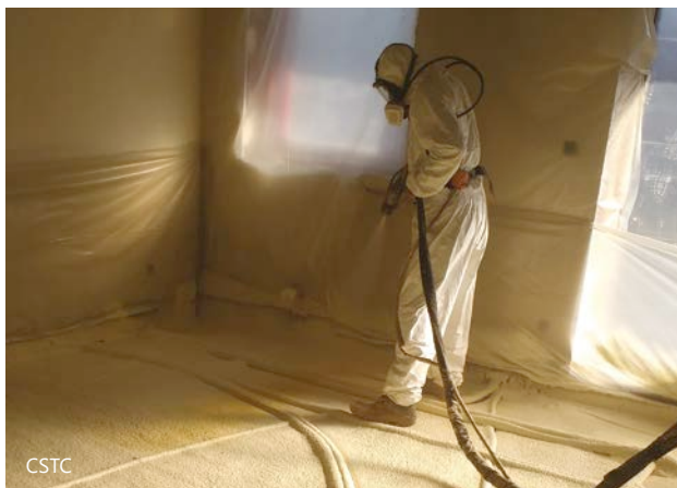
1 | Projection in situ de mousse de polyuréthane.
