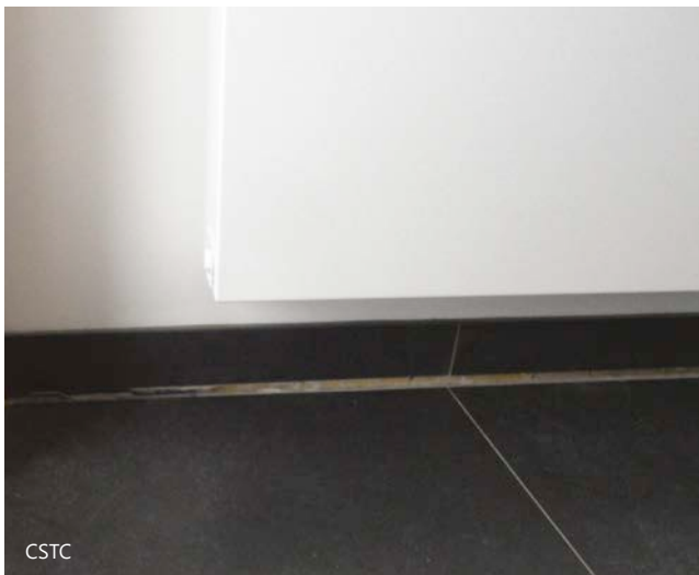
2 et 3 | Diverses pathologies observées à la suite d'un tassement de la mousse de polyuréthane projetée.
