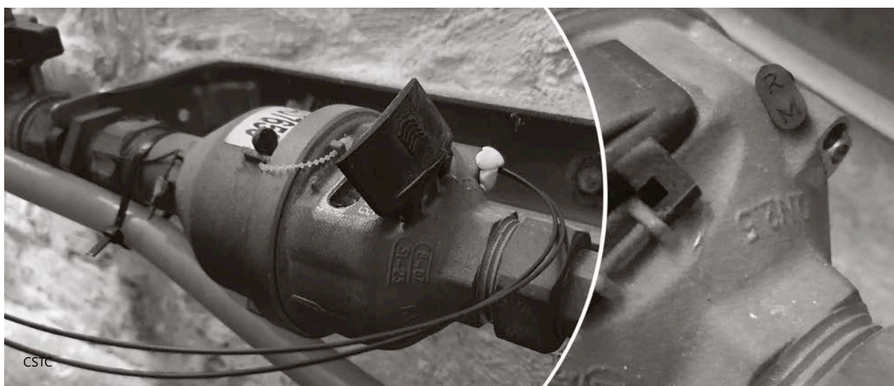
Détection indirecte des fuites : monitoring de la consommation dans une installation sanitaire à l'aide d'un compteur mécanique (avec fonction d'impulsion) équipé d'un capteur.
