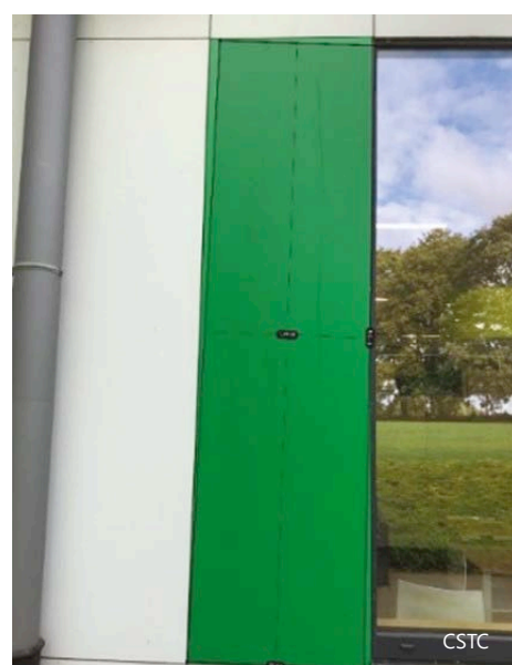
1 | Reconnaître les surfaces à l'aide de l'application 'Mesures'.
