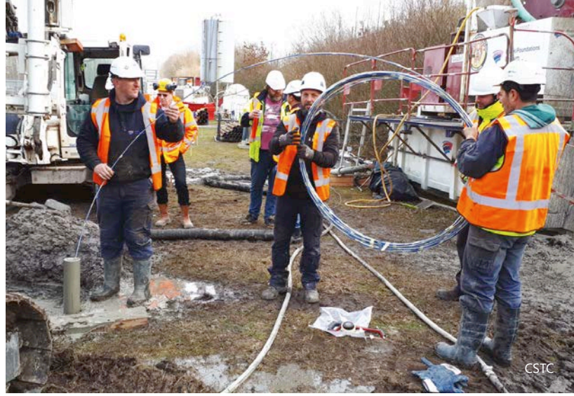
2 | Intégration de capteurs à fibres optiques dans un pieu vissé à refoulement (à gauche) et dans un micropieu (à droite).
