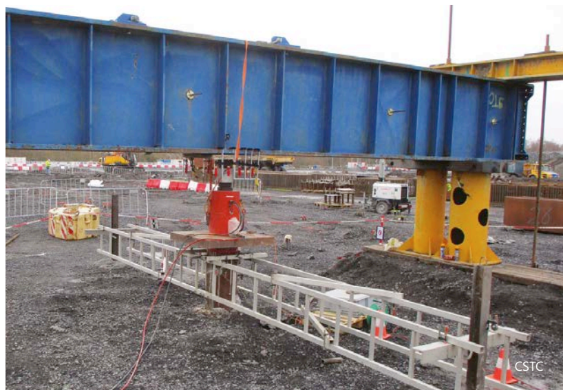
3 | Essai de chargement des pieux.
