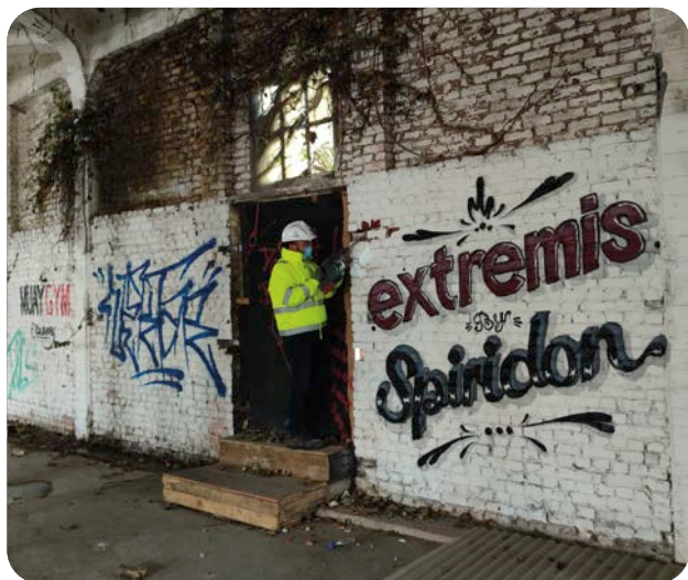
2 Demontageproef op een metselwerk uitgevoerd door de onderneming Galère.
