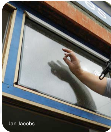
4 Plaatsing van een beglazing tussen twee glaslaten.
