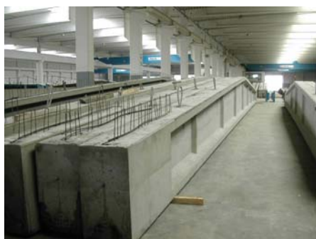
Afb. 3 Gebruik van HSB bij prefabricage.
