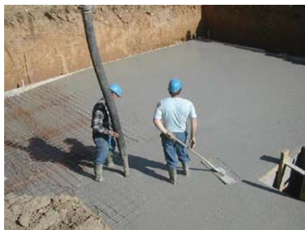
Afb. 4 Uitvoering van een zelfverdichtend beton.
