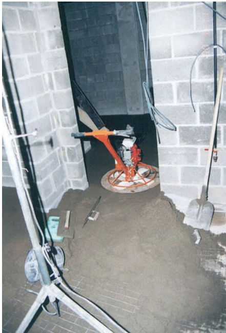
Afb. 2 Uitvoering van een manueel verdichte dekvloer.
