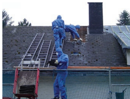
Ontmanteling van elementen uit asbestcement in buitenomstandigheden.
