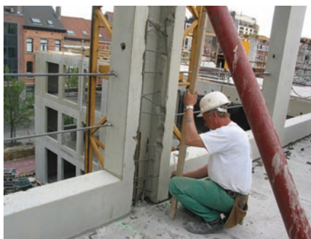
Betonnen kaderelement met geïntegreerde randbeveiliging onder de vorm van twee wapeningsstaven.
