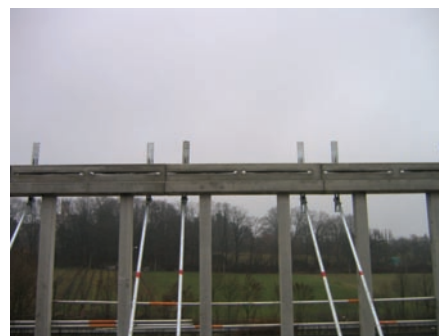
Duw- en trekschoor die de basis vormt voor de randbeveiliging van de volgende verdieping.
