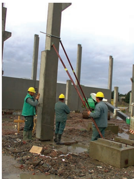
Gebruik van voldoende zware schoorblokken bij de montage van kolommen.
