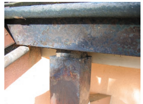
Corrosie ter hoogte van de aansluiting tussen de regenwaterafvoerleiding en de afvoergoot.
