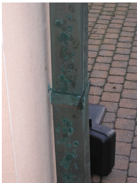
Blauwgroene verkleuring van een koperen regenwaterafvoerleiding en haar bevestigingsbeugel.
