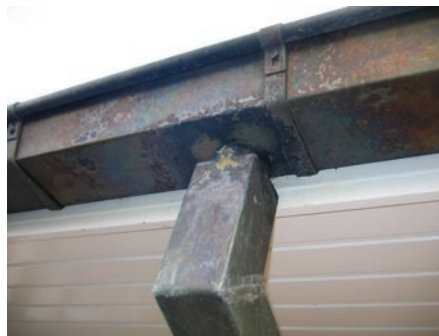
Corrosie ter hoogte van de aansluiting tussen de regenwaterafvoerleiding en de afvoergoot.
