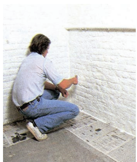
Afb. 11 Waterdichte bepleistering op basis van epoxyharsen.
