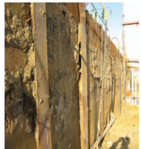
Afb. 2 Berlijnse wand (Wetteren).
