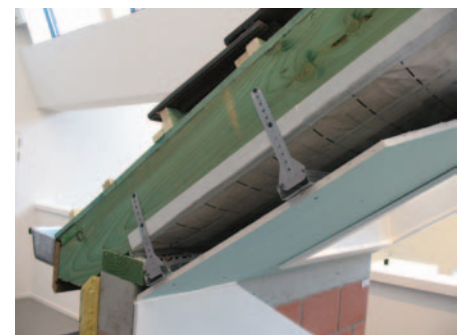
Afb. 1 Voorbeeld van een gedeeltelijk ont koppeld plafond.
